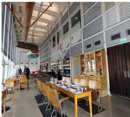
OAXEN KROG & SLIP – Sträckmetallskassetter på vägg med bakomliggande ljudabsorbenter som gör att ljudmiljön i lokalen blir behaglig.
