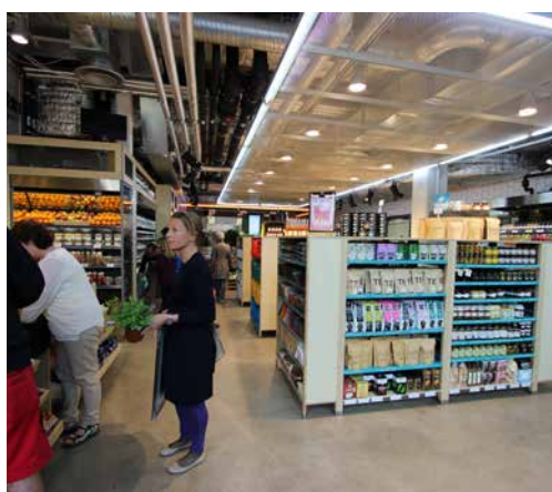
URBAN DELI – Frihängande luftigt innertak i obehandlad sträckmetall av aluminium.
