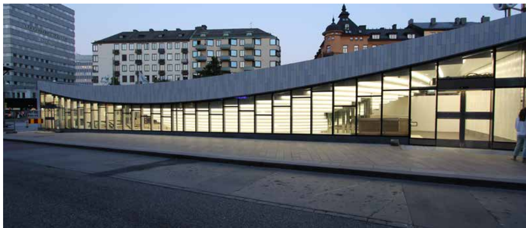
ODENPLANS NYA TUNNELBANESTATION – Specialtak i välvda etage med integrerad belysning.
