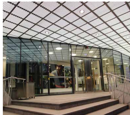
SKANSKAS HUVUDKONTOR – Undertak med specialperforering i form av Skanskas logotyp samt belysning.
